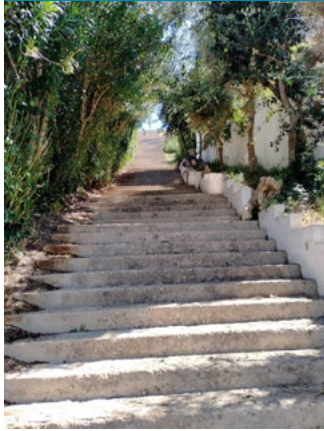
Mantenimiento de escaleras. Maintenance of steps.
